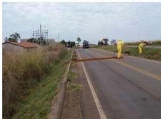
Construção do dique de contenção utilizando solo.
