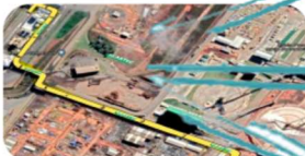
Tubulação de Hidrogênio entre a planta química e planta de papel e celulose.
