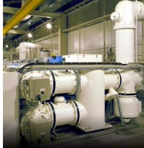
2 Switchgear
